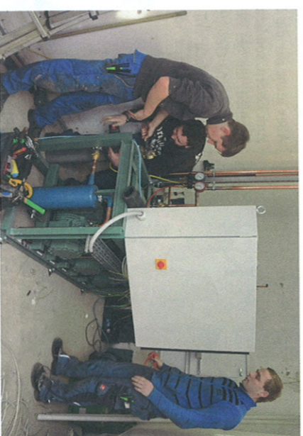
Letzte Vorbereitungen durch Azubi Paul Schaaf (v.l.) und Sören Hammer damit die Dichtsprüfung der Kälteanlage in Langenbogen durch den zuständigen Bauleiter vorgenommen werden kann.
